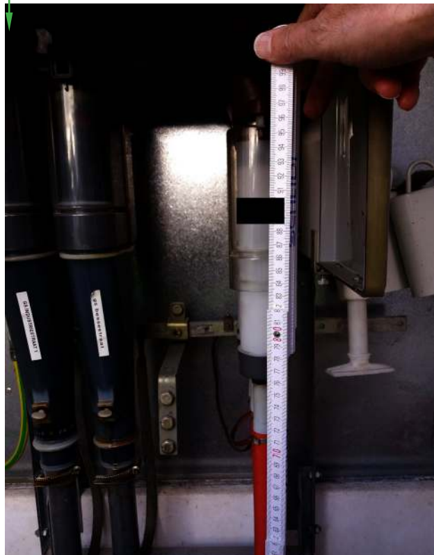
FIG. 3 Kritische hoogte van een verdeelstation
